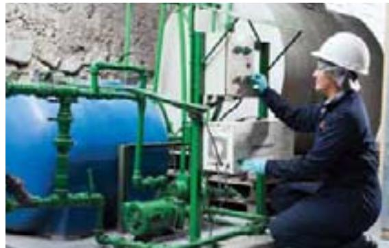
Se estima que, gracias al proyecto de reutilización del agua de ósmosis, se recuperarán 450 m<sup>3</sup> de agua anualmente, mediante un sistema que incluye un tanque de recepción, una bomba para elevar la presión y tubería PVC para llevarla a la cisterna. **El costo de inversión del proyecto es US \$ 1250,00 y genera un ahorro estimado de US \$ 6500,00.**
